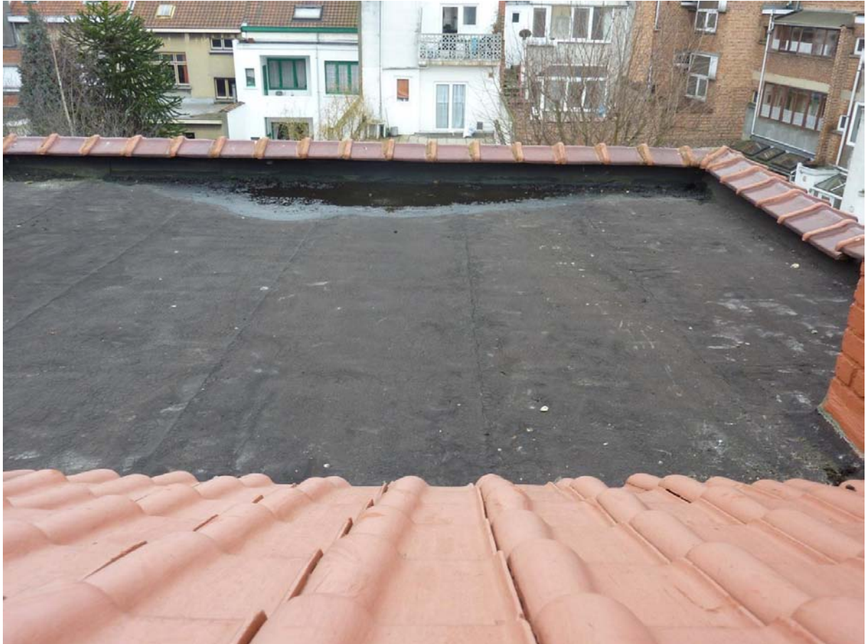
Toiture plate à isoler
