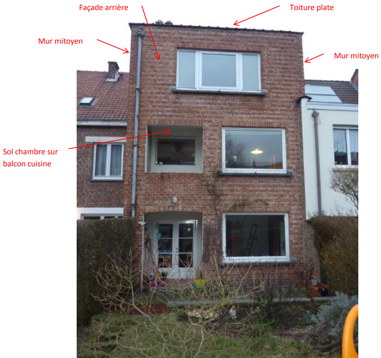
Façade arrière, chambre au 2 ème étage, sous toiture plate
