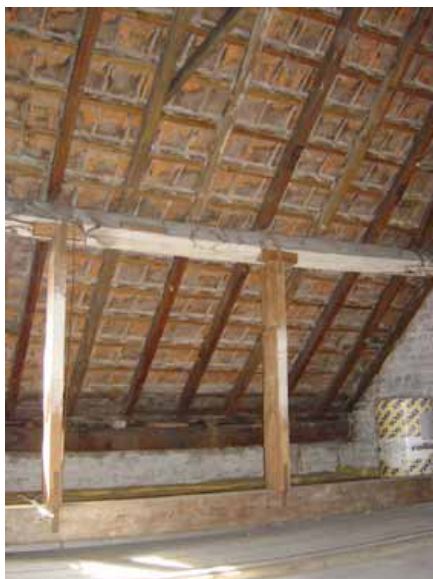
Toiture non isolée
