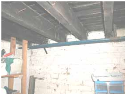
Plafond de cave
