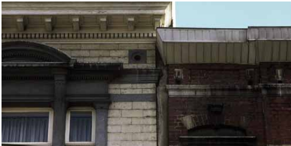
A droite: corniche habillée de lattes en PVC (photo AAM, Bruxelles).
