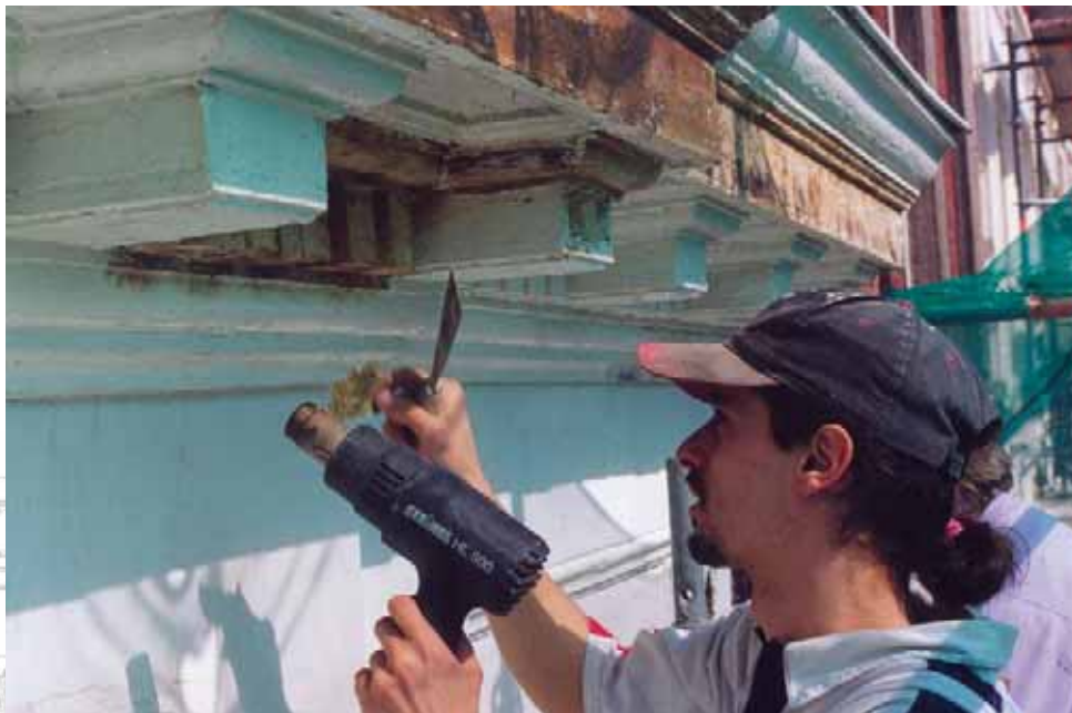
Décapage thermique avant remise en peinture.
