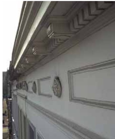
Rue du Mont-Blanc 29 – (photo AAM, Bruxelles).
