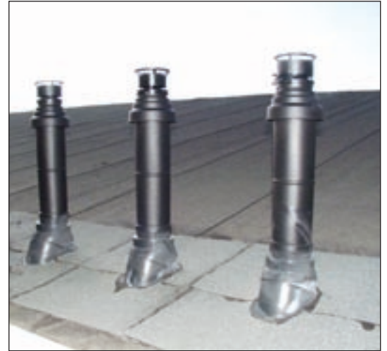
Terminaux verticaux au-dessus d'une toiture
