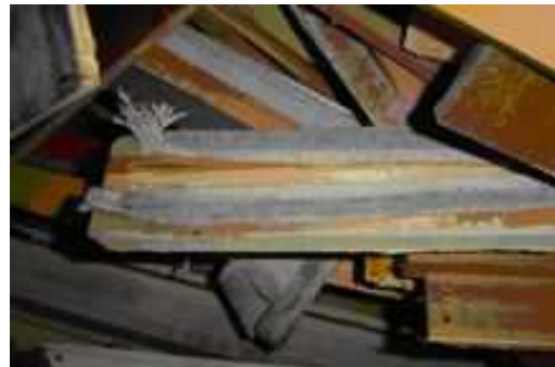
Photo 20 :Rubans à l'arrière de chambranles de porte
