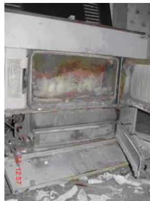
Photo 22 :Cordes sur le cadre de la porte d'un poêle et sur la porte du tiroir à suies
