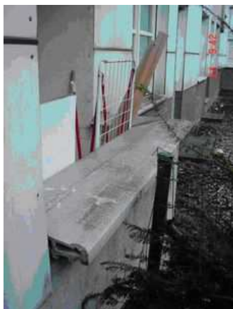
Photo 3 : Couvre mur en amiante-ciment (structure alvéolaire) et plaques de façade en amiante-ciment de type « Glasal » (couche de finition blanche extérieure)
