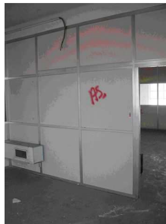
Photo 2 : Plaques « Glasal » ou « Cloisal » : cloisons intérieures de bureau
