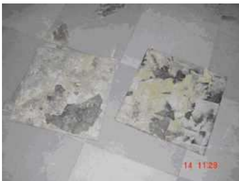
Photo 24 :Dalles vinyles bicolores et résidus de colle noire au dos de celles-ci
