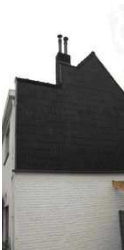
Photo 7 : Ardoises noires en amiante-ciment sur le pignon d'une habitation et cheminées en amiante-ciment
