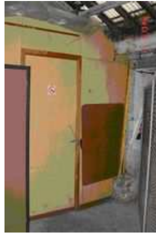
Photo 12 : Cloison constituée par de fines plaques jaunâtres de type « Menuiserie »
