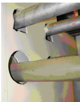
Photo 41 : Cloison constituée de plaques blanchâtres à grisâtres de type « Pical » : le gaufrage de la face intérieure est caractéristique
