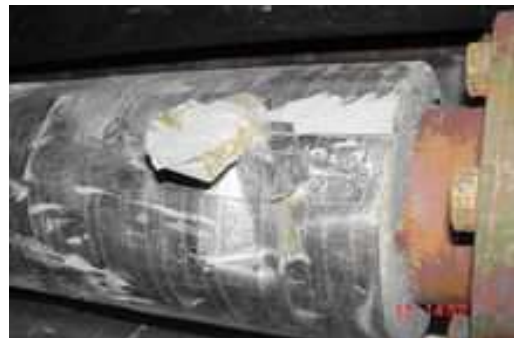
Photo 16 : Carton amianté entre deux feuilles d'aluminium, autour de l'isolation de conduites de chauffage
