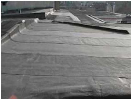
Photo 45 : Certaines membranes d'étanchéité de toiture (« Roofing ») peuvent contenir des fibres d'amiante
