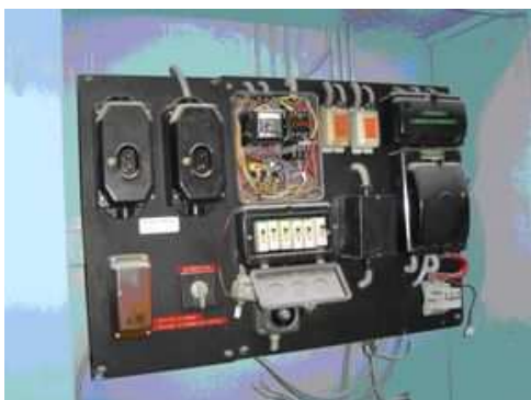
Photo 26 : Plaque noire support électrique (des tablettes de fenêtre, des seuils de porte, des plinthes peuvent être faits la même matière)
