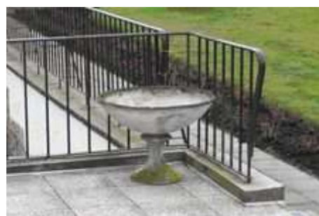
Photo 4 : Vasque en amiante-ciment
