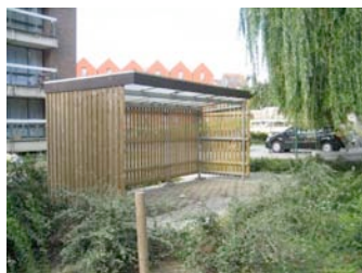
Abri pour conteneurs ...
