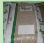
Sacs plastiques de sable et gravier
