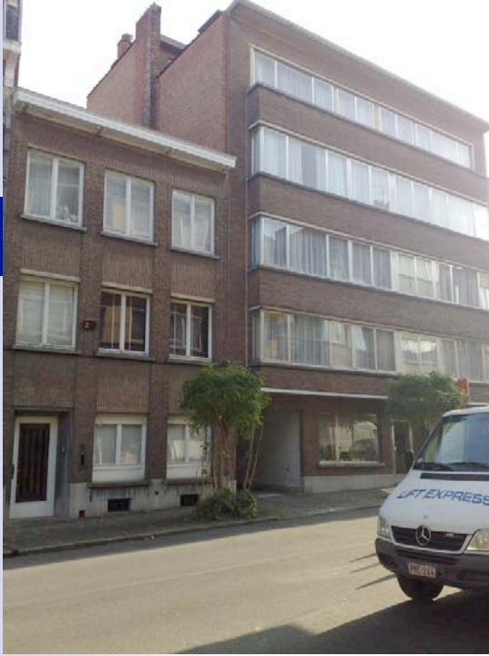
Architecture des années 60/70 Architectuur van de jaren 60/70
